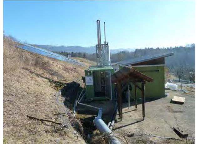
Schwachgasentsorgungsanlage CHC 25, Firma LAMBDA
