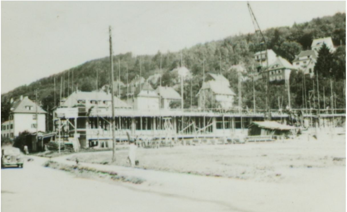
die Gewerbeschule im Rohbau 1953
